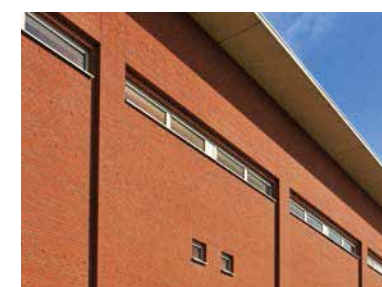
Zakład Uzdatniania Wody we Wrocławiu s. 20
